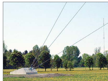
Abspannung der Antennenmasten
