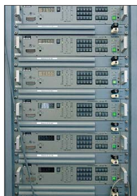
Ball-Monitorempfänger, hier für die UKW-Signale vom Wendelstein
