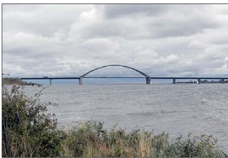
Ein Teil der Brücke über den 1300 m breiten Fehmarnsund Fotos: DL2VFR (6), DL7UXG (1)
