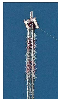
Abspannung der Antennenmasten
